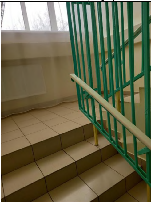
Фото №9 Лестница (внутри здания)
