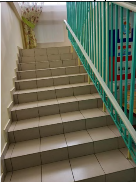
Фото №7 Лестница (внутри здания)
