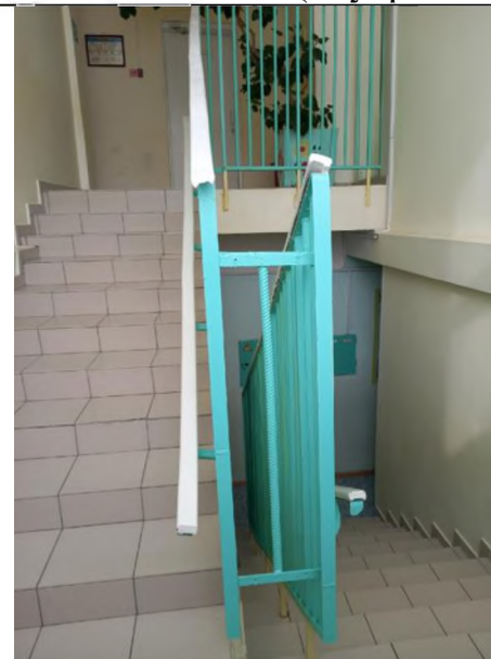
Фото №8 Лестница (внутри здания)
