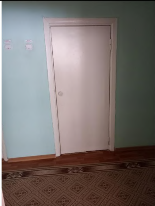
Фото № 25 дверь в туалет на 1 этаже
