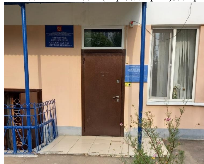
Фото № 4 Входная площадка (перед дверью), дверь (входная)
